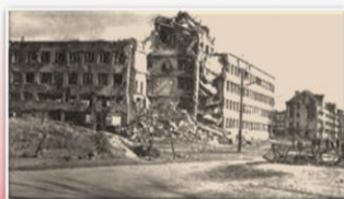
Ruiny „Szklanego domu”, w którym zginęły 4 siostry
